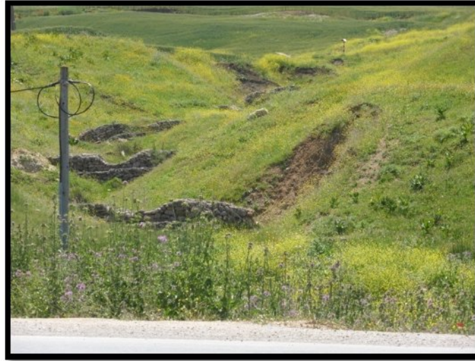
Photo 14 : Correction des chaabets en gabions à Ain Tine
